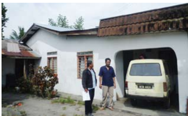
Fitri di depan rumahnya yang sudah dibaiki bumbung
