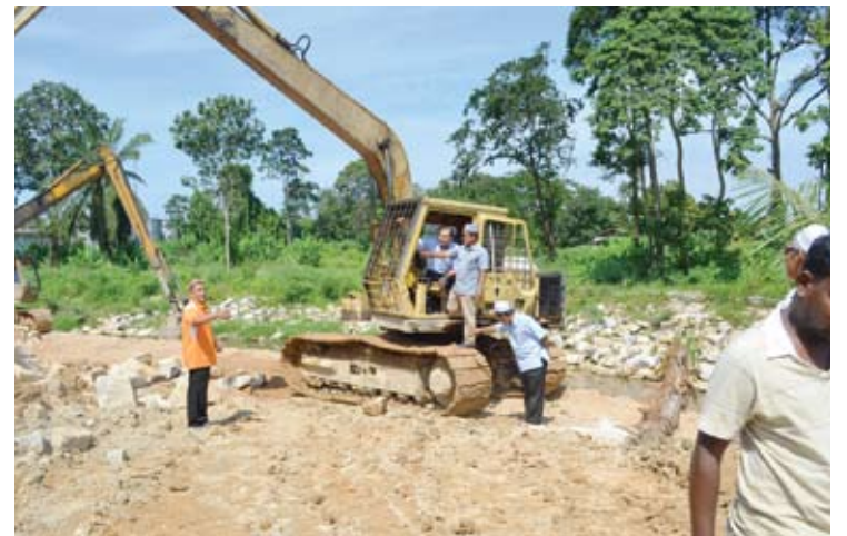
Pembinaan jambatan konkrit dibuat serta-merta apabila jambatan lama rosak teruk akibat banjir
