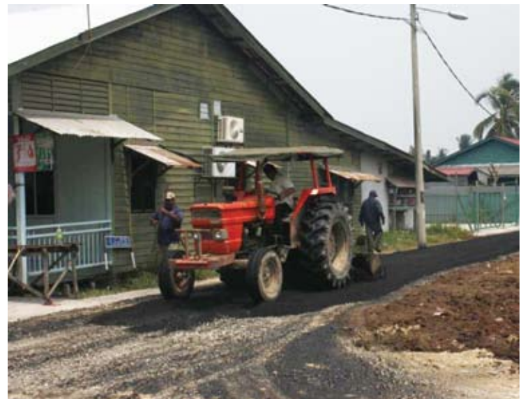
Kerja-kerja naik taraf jalan dilakukan dalam masa sehari
