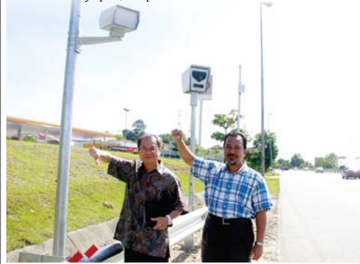
TIDAK SAH... pemasangan AES tidak mendapat kebenaran MPSp
