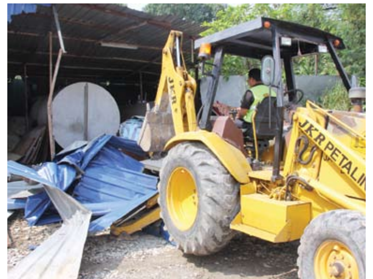
Tangki yang dipercayai digunakan menyimpan diesel
