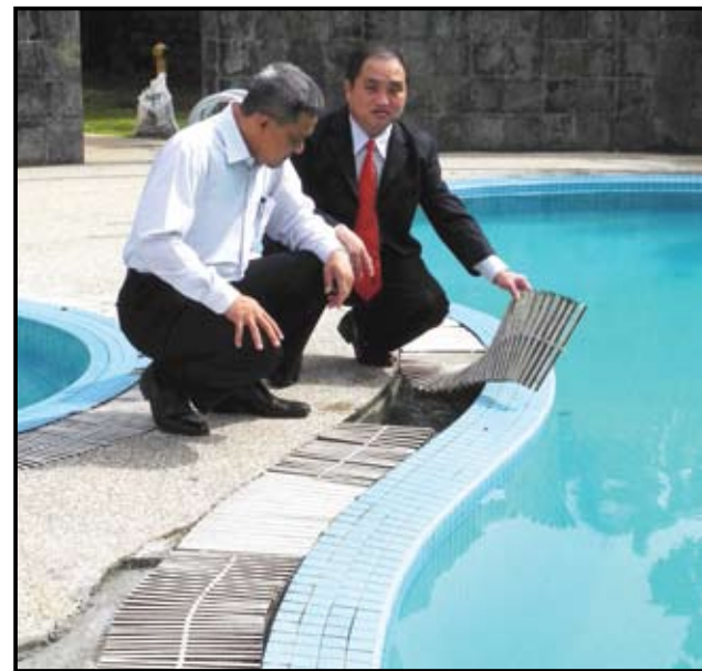
▲泳池踏板不稳固，导致黄瑞林(右)一脚踏空险些跌倒。
