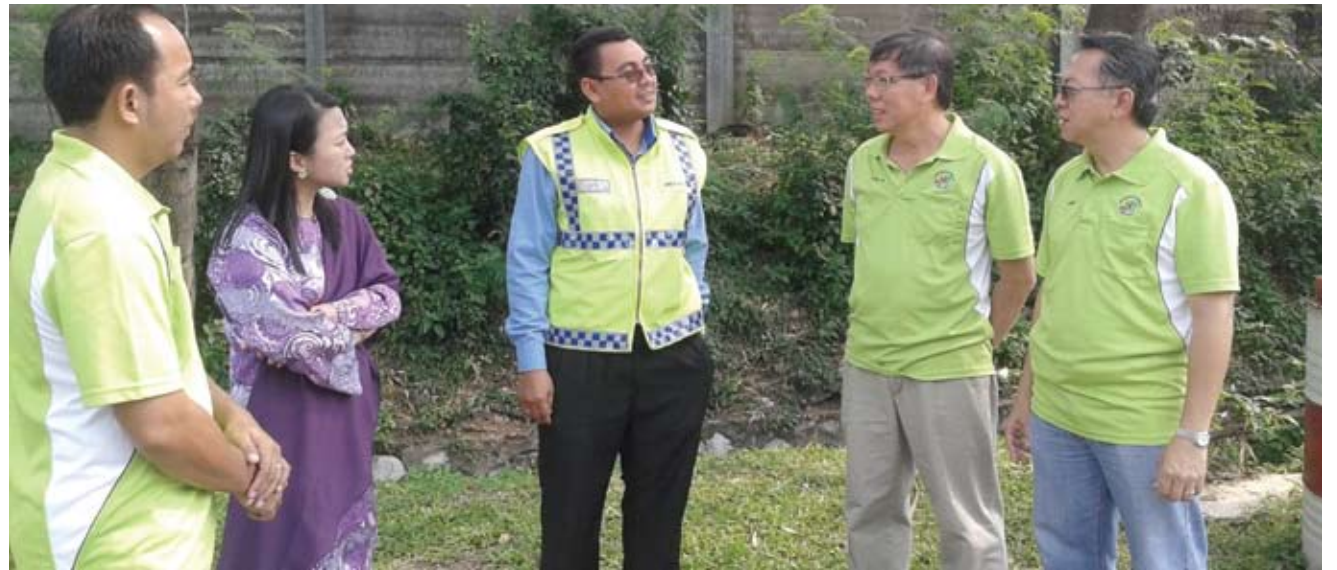
Hannah mendengar penerangan wakil KESAS berhubung retakan pada batas bunyi sepanjang Lebuhraya Shah Alam dan UEP Subang Jaya
