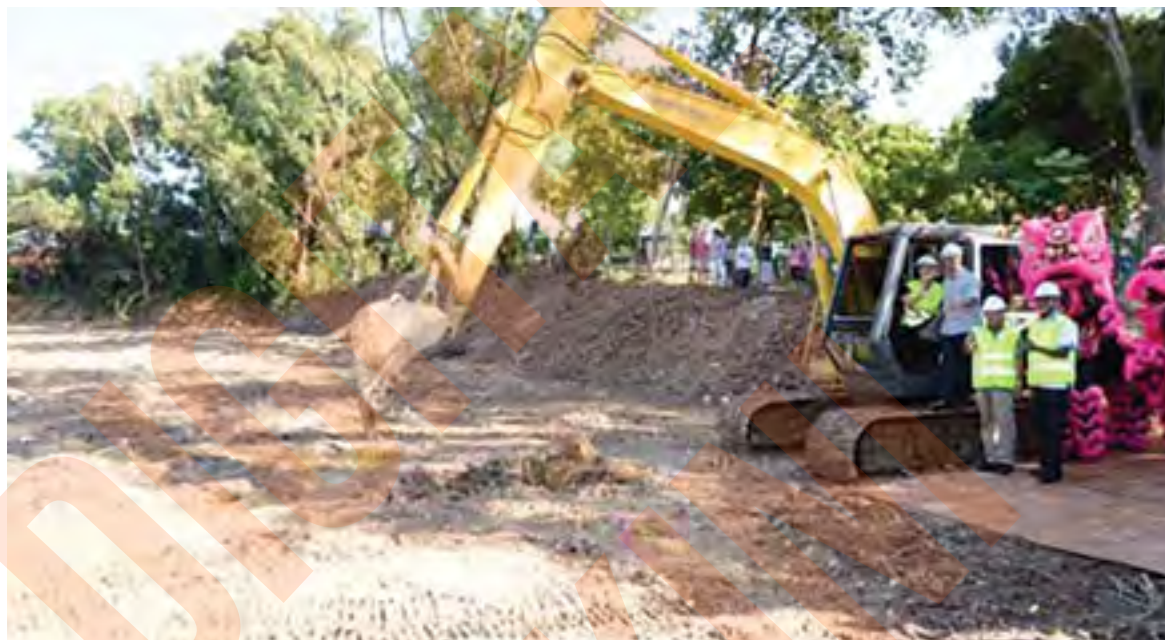
Kerja pembinaan dewan komuniti dua tingkat di Bandar Utama 11 sedang giat dijalankan bagi memenuhi keperluan dan permintaan daripada komuniti setempat
