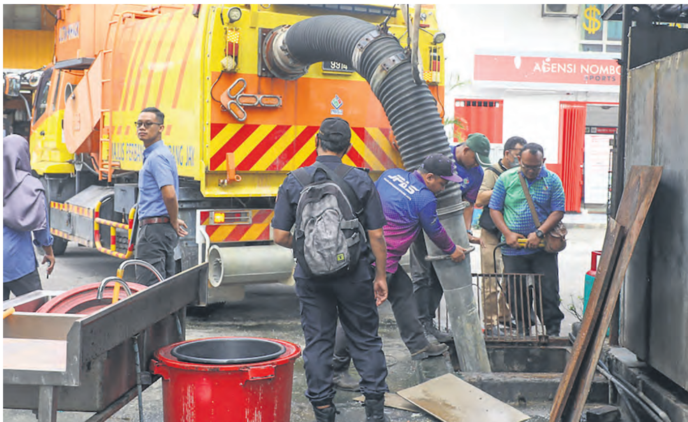
GIGIH... Kakitangan Majlis Bandaraya Subang Jaya melakukan kerja pembersihan longkang ketika Operasi Peruntuhan Struktur Atas Longkang di Jalan USJ 1/19, Subang Jaya pada 7 Jun. Foto REMY ARIFIN
