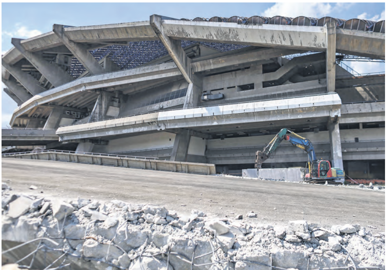
Kerja meroboh Stadium Shah Alam dijalankan kontraktor Malaysian Resources Corporation Berhad (MRCB) bermula 1 Julai untuk membangunkan kompleks sukan serba moden dan berteknologi tinggi yang pembinaan fasa pertama dijadual siap pada 2026. Foto ZULFADHLI ZAKI ▶ BERITA MUKA 6
