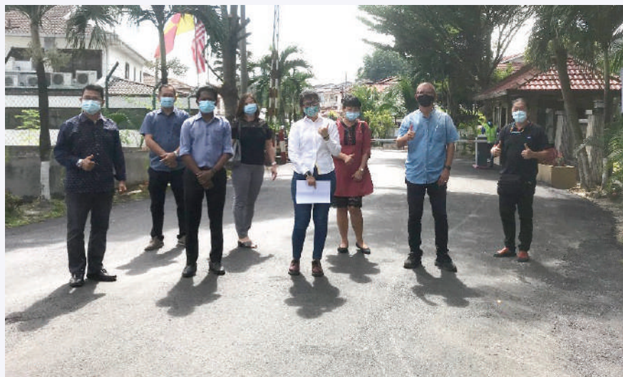
▲无拉港区州议员王诗琪(左五)巡视陈明再也的铺路工程进度, 右2为神建华。
