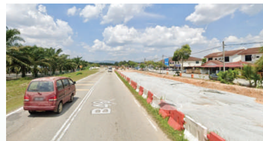
▲一旦B48联邦公路提升工程竣工，将为双溪比力打开一道经济大门。
