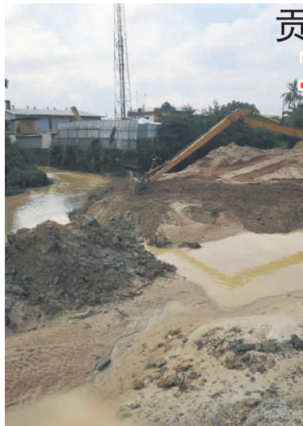
▲鹅唛贡河如火如荼施工以展开防洪工程。
