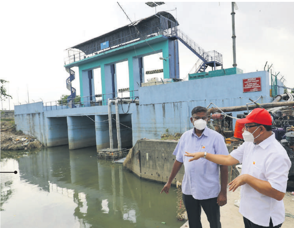
►雪州行政议员依兹汉(右)和同僚甘纳巴迪劳巡视太子园的水闸情况。
