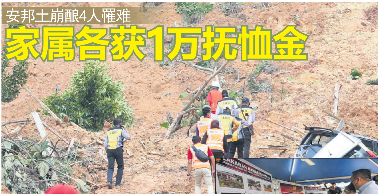
▲公共工程局及大马公共工程研究院官员检查武吉柏迈(2)花园土崩现场的土质情况。
