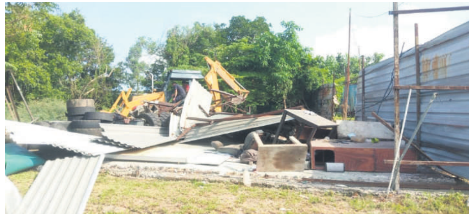
▲巴生县土地局官员拆除非法兴建在巴生班达马兰工业区花园政府地段上的数间建筑物。
