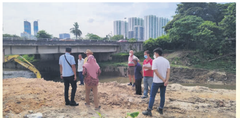
▲承包商实地考察金銮花园河岸提升工程，确保工程能顺利展开。
