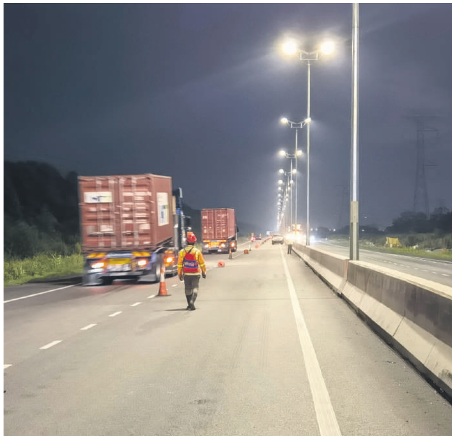
▲雪州公共工程局分阶段在巴生港口州选区安装742盏LED路灯。
