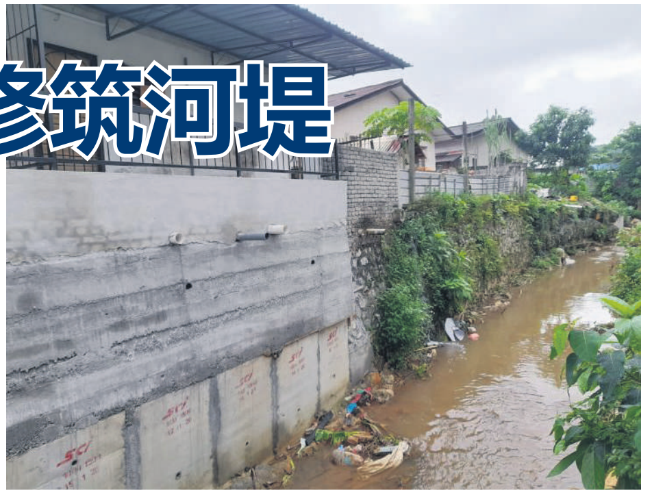
▲太平村迪沙阿曼河的河堤已获修复，令村民无需担心土蚀所引起的地陷问题。
