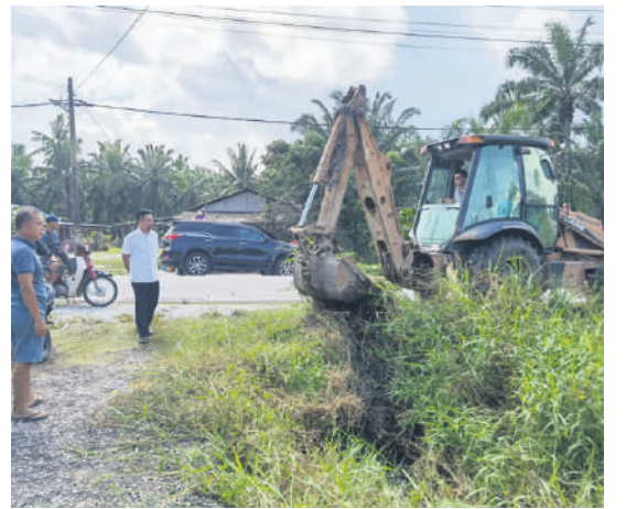
▲巴生港口区州议员阿兹米占巡视选区的沟渠挖掘工作进展。
