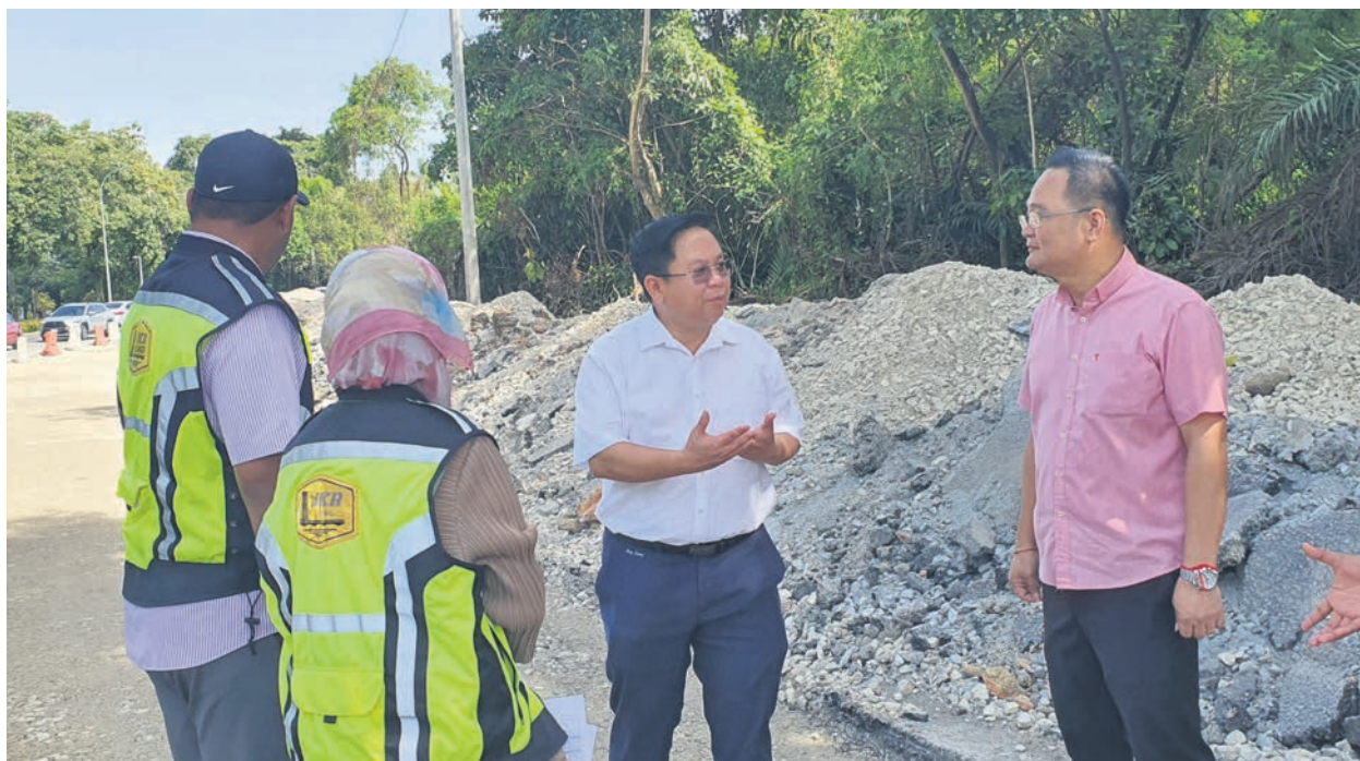
▼班达马兰区州议员梁德志(右2)在巴生市议员洪建华(右)陪同下巡视金泉路沟渠和道路提升工程。
