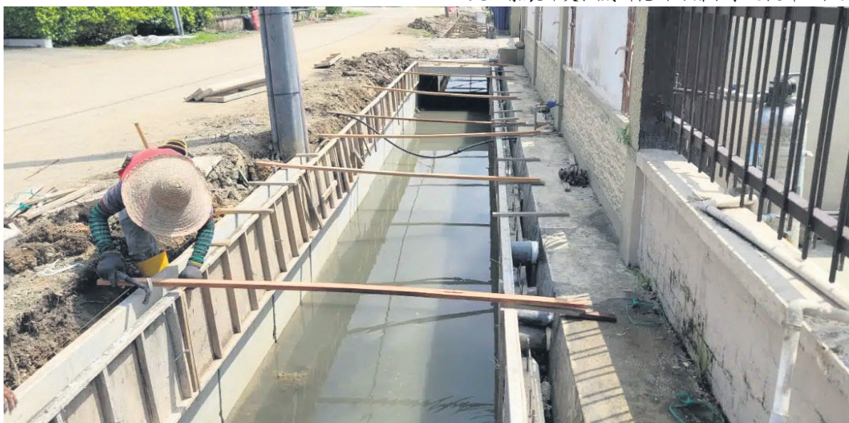
▼工人如火如荼展开美拉威斯花园的排水系统提升工程。
