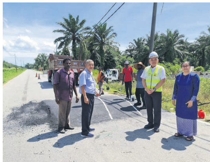
▲刘永山（左3）巡视选区内其中一项铺路工程。
