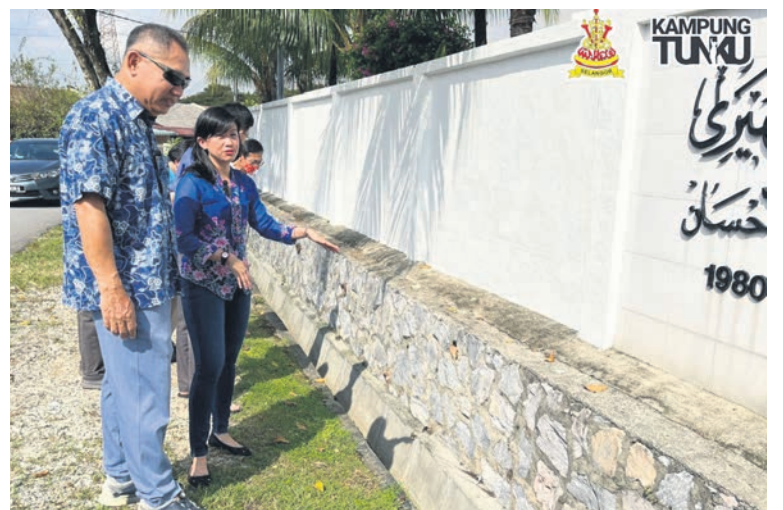
▲林怡威(左二)与居民巡视沟渠加宽工程。
