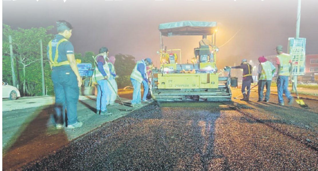
▲大规模铺路工程预计在9月份全面完工。
