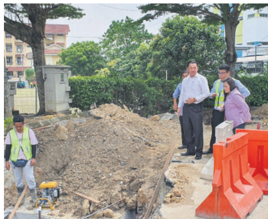
▲张睫洋 (右3) 巡视加影育华国民型中学校外的排水系统提升工程。
