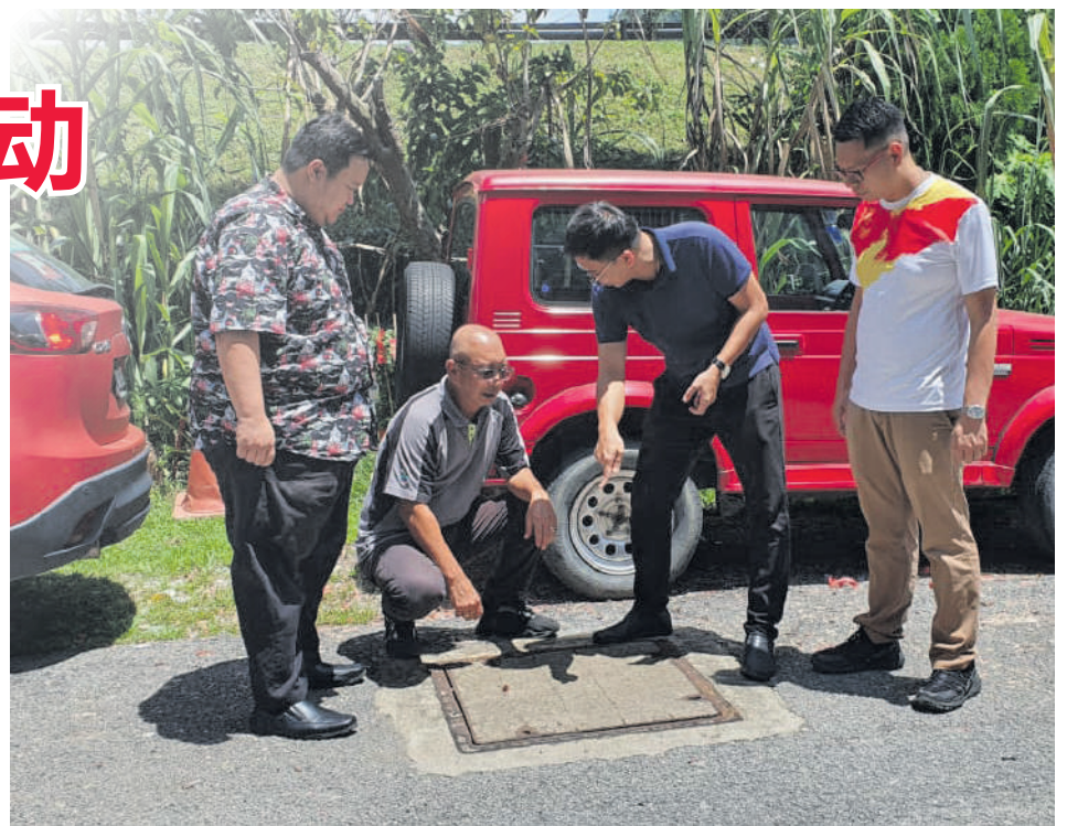
无拉港区州议员王俊伟(左2)巡视发生电缆偷窃案的地点。
