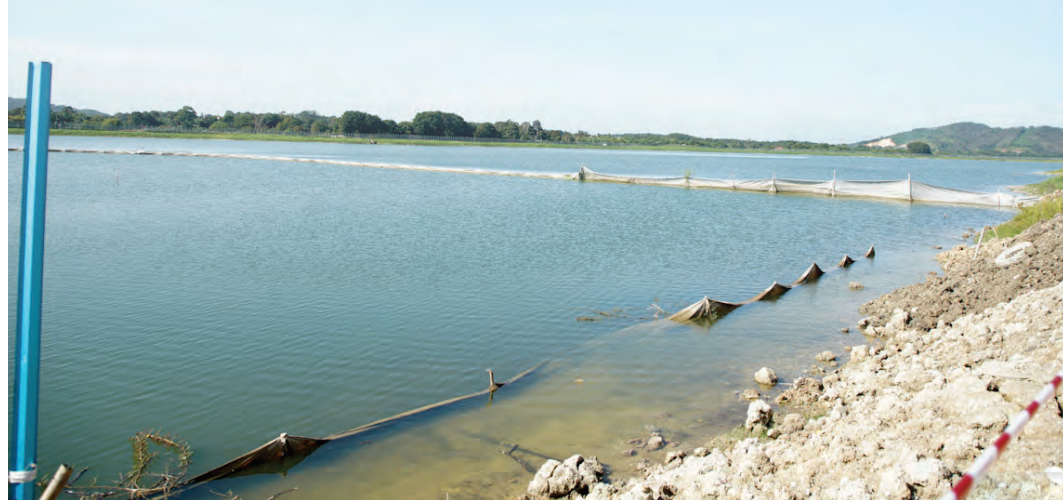
▲位于雪邦的雪州生水保障计划的蓄水池兴建工程已完工。
