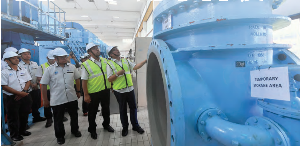
▲雪州行政议员依兹汉(右)巡视雪兰莪河第一期滤水站的设施。
